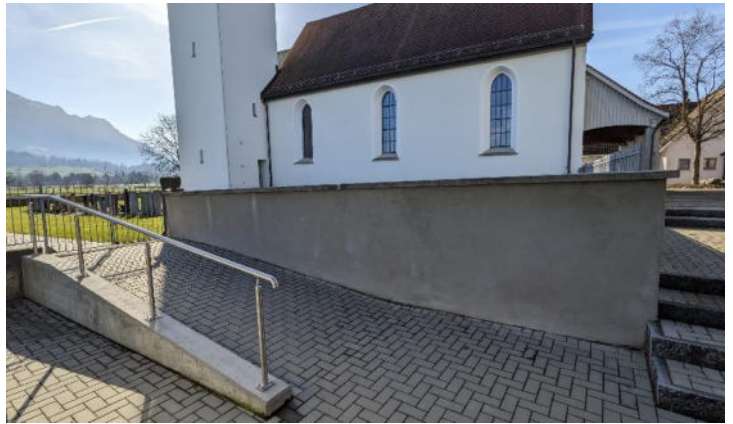
Die neu instandgestellte Mauer mit dem stufenlosen Aufgang von der Aufbahnhalle zur Kirche in Salez.
