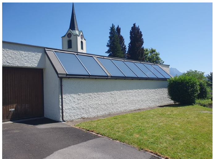
Folie bei den Glasdächern der Aufbahrungshalle in Sennwald Foto: Hansueli Dütschler
