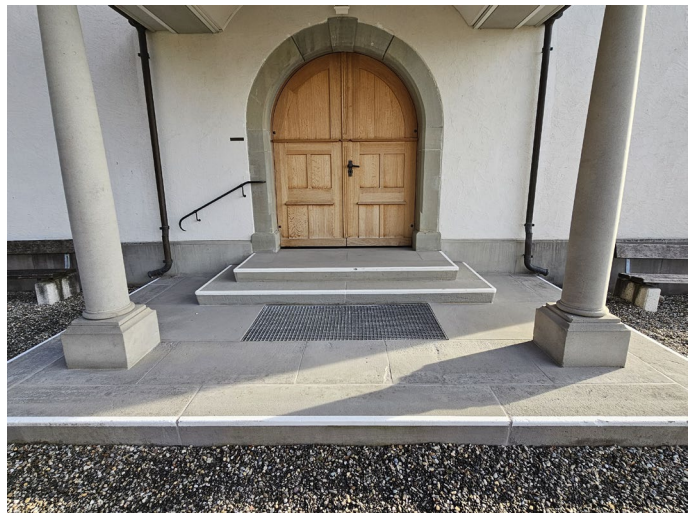
Eingang bei der Kirche in Sennwald Foto: Hansueli Dütschler
